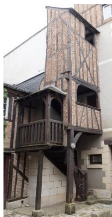
Une cour intérieure
