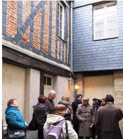
Les colombages ont été recouverts d'ardoises pour les protéger des intempéries.
